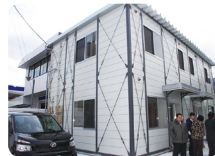
大船渡・陸前高田地区復興支援・仮設クリーニング工場(上が共同洗いの建物内、下が共同仕上げ場の建物外観)
