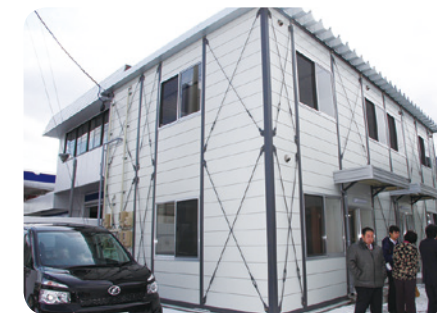
大船渡・陸前高田地区復興支援・仮設クリーニング工場(上が共同洗いの建物内、下が共同仕上げ場の建物外観)
